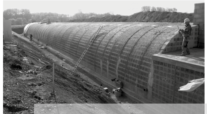
Der Gewölbekeller entsteht
